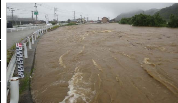
平成26年8月9日出水 波瀬川3.4k付近 津市一志町
