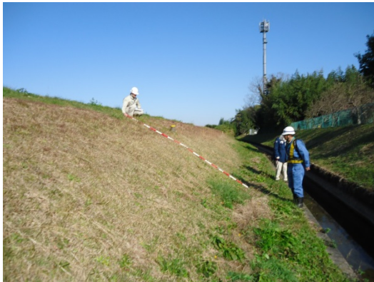
H27施設点検状況
