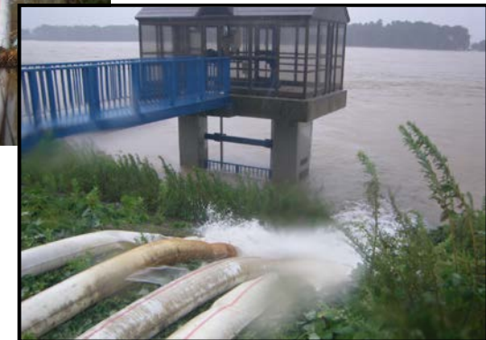
排水作業状況
