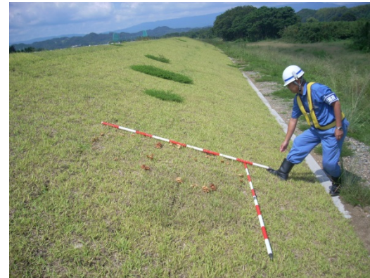
H27施設点検状況
