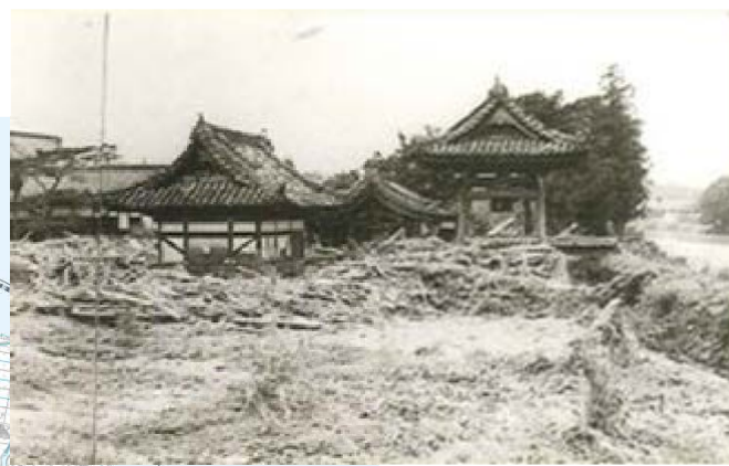
櫛田川左岸の越水 多気町射和(当時)
