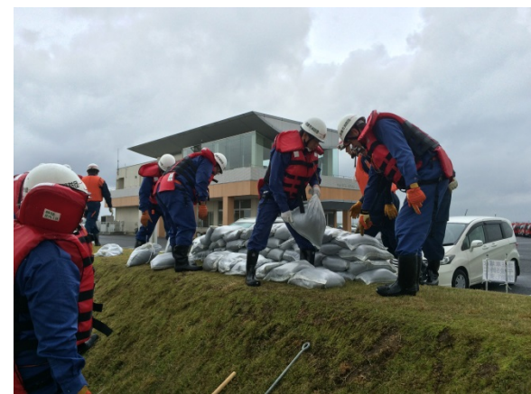
積み土のう工法
