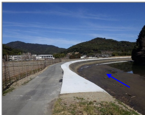
押淵川における護岸整備（堤防強化） （左：施工前 右：施工後） （三重県）
