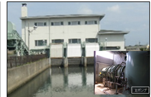
江川排水機場施設の延命化 (三重県)
