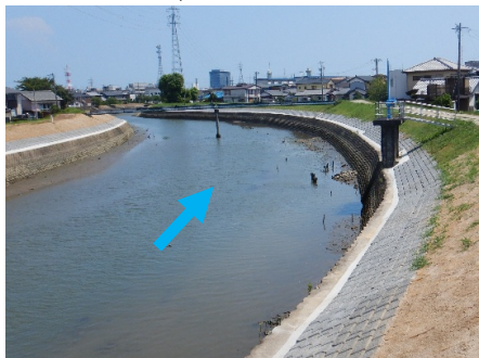
岩田川における築堤護岸 (三重県)
