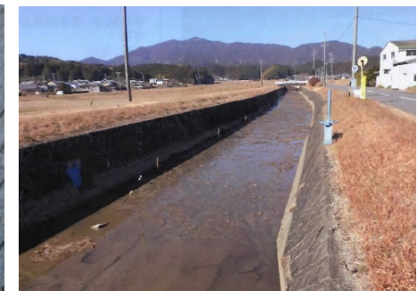
津市内河川における河道掘削 (津市)
