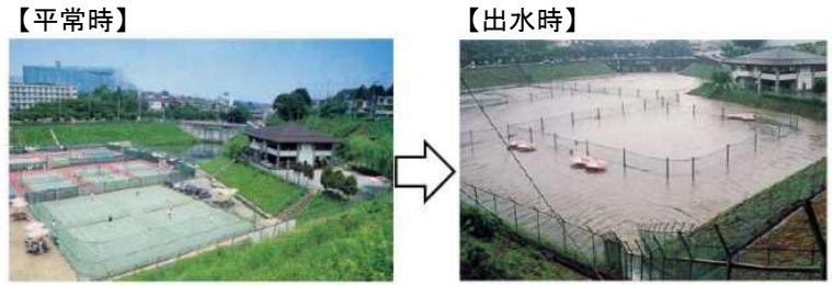
雨水貯留浸透施設の例(防災調整池)
