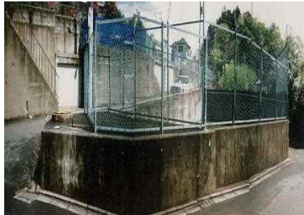
従前の防災調整池
