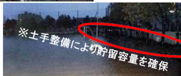
【校庭を活用した貯留施設】
