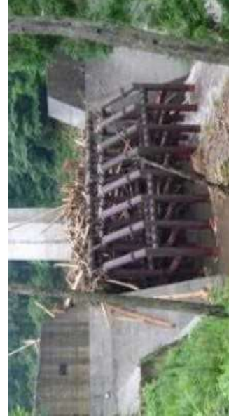
土砂や流木を効果的に捕捉する遊砂地等の設置
