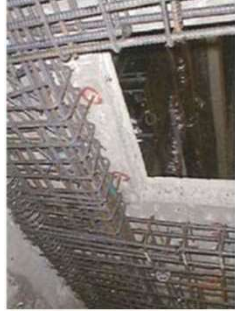
処理場の耐震化 (躯体補強)
