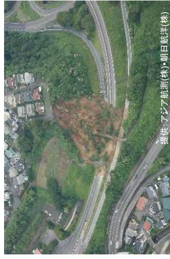
逗子ICにおけるのり面崩落 (神奈川県逗子市)
