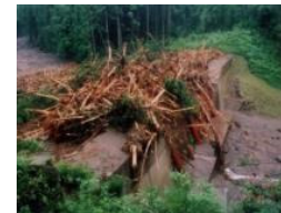
流木捕捉式治山ダム
