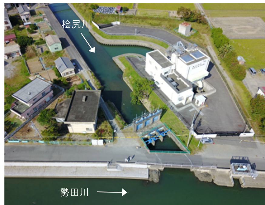
勢田川（伊勢市） 桧尻川排水機場増設
