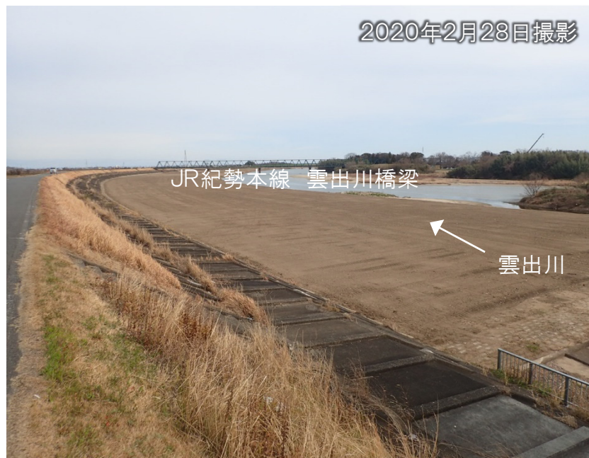
雲出川下流部（津市） 河道掘削実施状況
