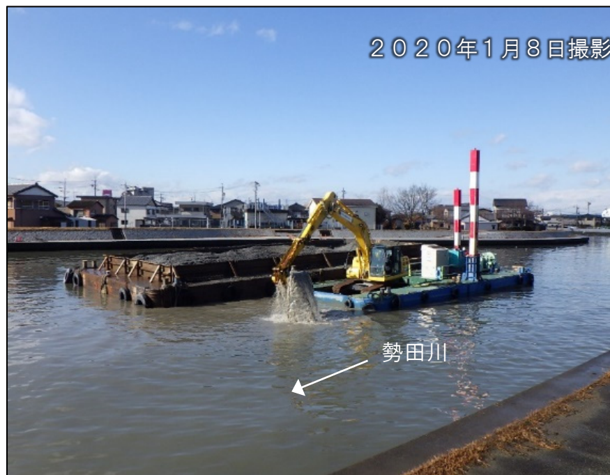
勢田川（伊勢市） 河道掘削実施状況
