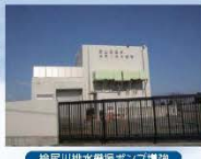
椋尻川排水機場ポンプ増強
