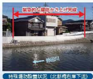
特殊運動防護壁状況(北新橋右岸下流)
