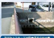
逆流防止フラップ弁設置予定の排水管
