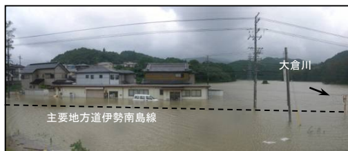
平成23年9月洪水 洪水における浸水状況(大倉川流末)
