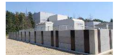
耐水化(防水壁の設置)
