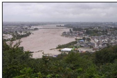
平成16年9月洪水 堤内地浸水(宮川右岸7.4km付近) 3
