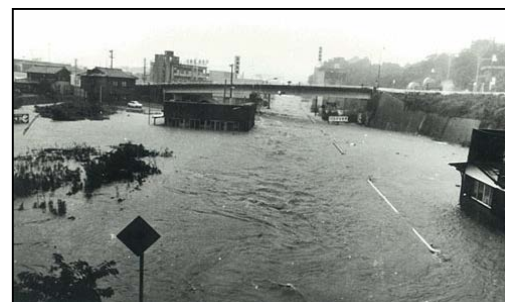
昭和49年7月洪水 浸水状況 (亀山市駅前)
