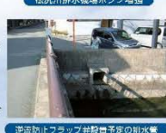
逆流防止フラップ弁設置予定の排水管
