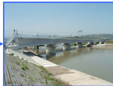
近鉄新中村川橋梁
