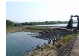
魚道の有る堰: 本川の雲出井頭首工
