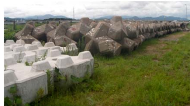
水防資材の備蓄状況(宮川左岸3.8k付近)
