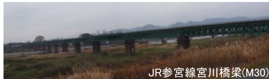
JR参宮線宮川橋梁(M30)
