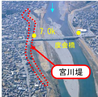
宮川堤（宮川右岸7.0k付近）
