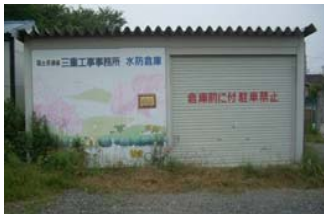
水防倉庫(宮川右岸7.0k付近)
