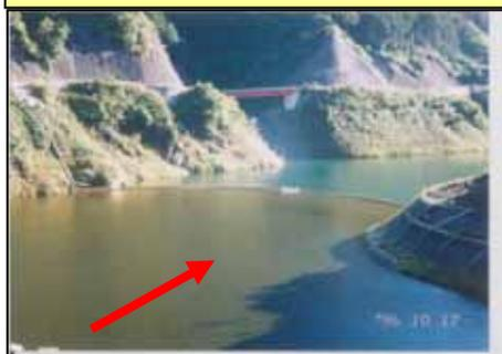
現在設置されているフェンスによる淡水赤潮拡散防止効果は認められるが、今後は表層部の水温低下、受光量の減少によるプランクトンの増殖抑制を図る曝気循環方式による水質改善に向けた検討を行う。
