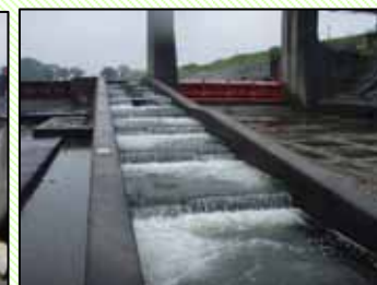
階段式魚道 (流量増加時)
