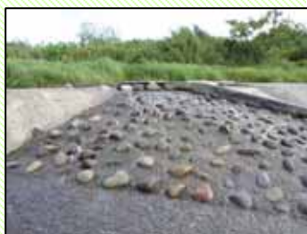
粗石付き斜路式魚道 (流量低下時)
