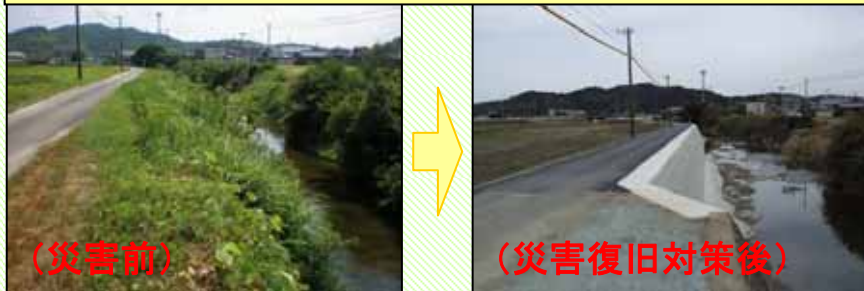
災害復旧(佐奈川4.4k左岸付近)
