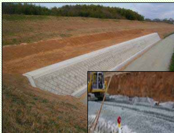
漏水対策(ドレーン工法)
