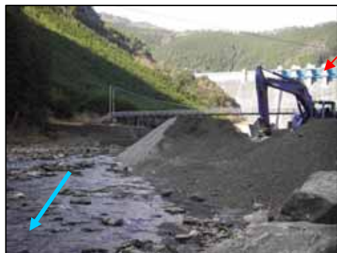
土砂投入状況
