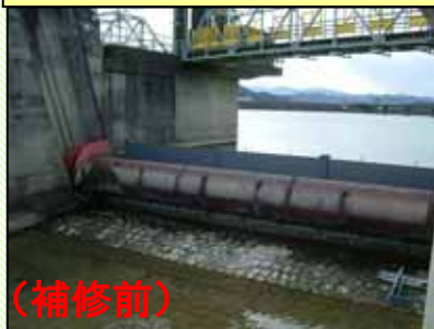
櫛田可動堰ゲートの補修
