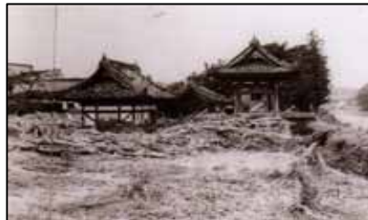
松阪市射和町の浸水後の状況
