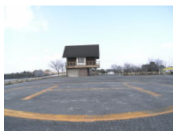
防災拠点（西山公園） （雲出古川右岸2.0km付近）
