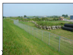
ブロック備蓄状況 （雲出川右岸3.2km付近）
