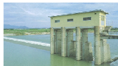
笠松頭首工(雲出川6.3km) 昭和26年完成
