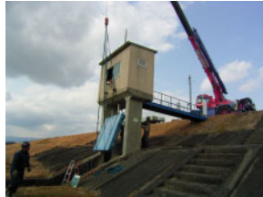
元町排水樋管の補修状況 (雲出川 右岸9.5k付近)
