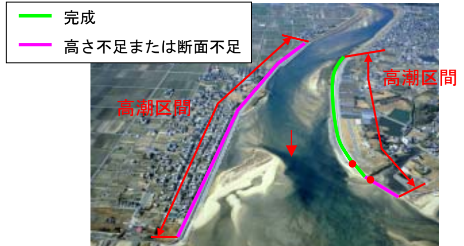
高潮区間と高潮堤防整備状況（雲出川）
