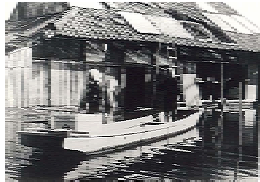
伊勢湾台風による被災状況
