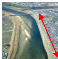
香良洲地区 築堤箇所
