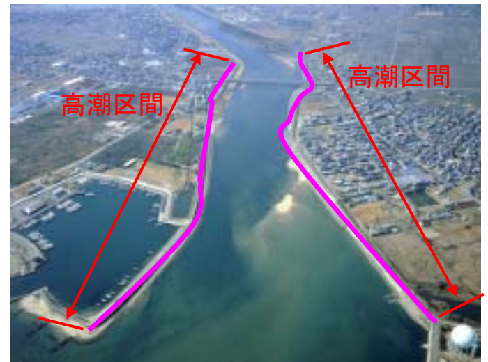
高潮区間と高潮堤防整備状況（雲出古川）
