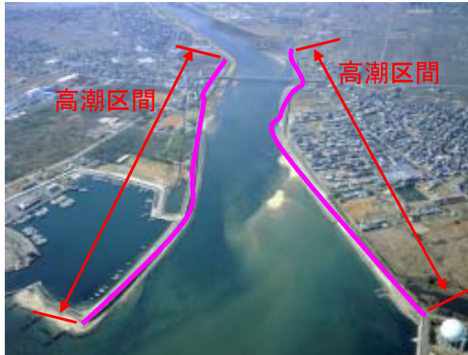
高潮区間と高潮堤防整備状況（雲出古川）
