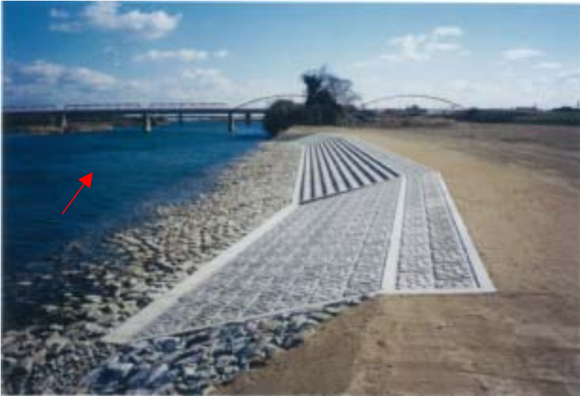
低水護岸（雲出川右岸3.8k付近）
