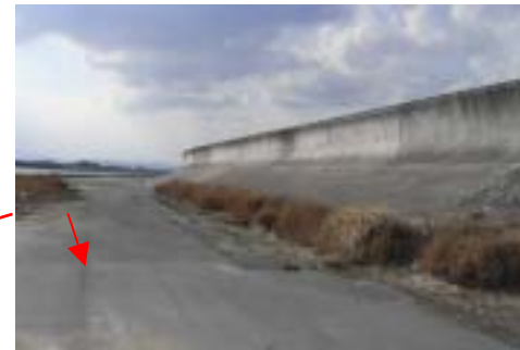
高潮堤防（完成堤防）
