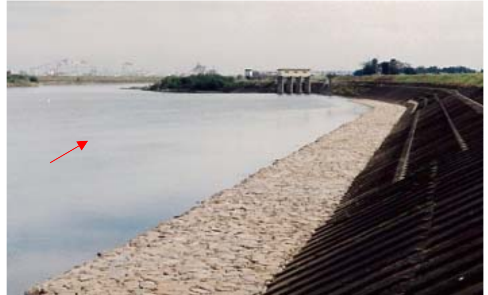
根固め工（雲出川右岸6.6k付近）
