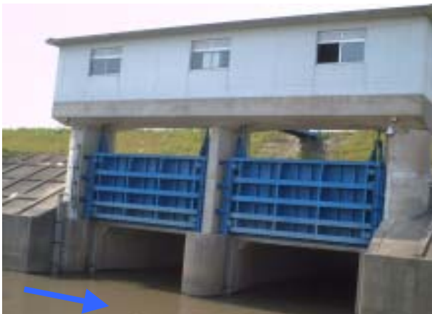
前田川排水ひ門 (雲出川 左岸5.4k付近)
