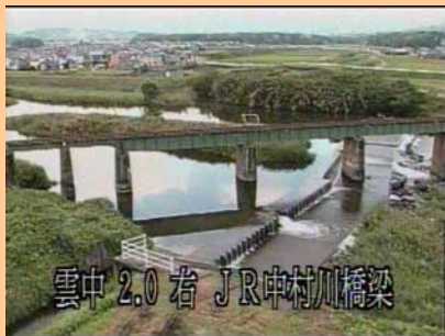
CCTVカメラによる映像
