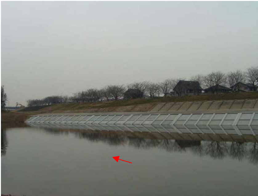
低水護岸（中村川1.8k付近）
