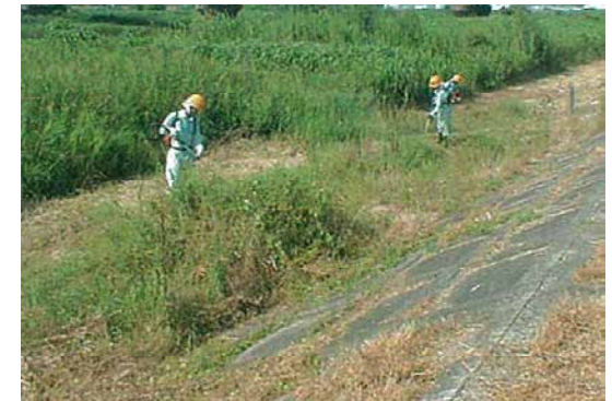
堤防除草の作業状況
