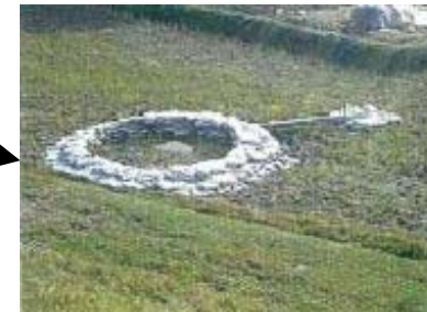
基盤漏水 (雲出川右岸6.2km)
