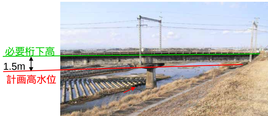
桁下高不足の橋梁（近鉄新中村川橋梁）
