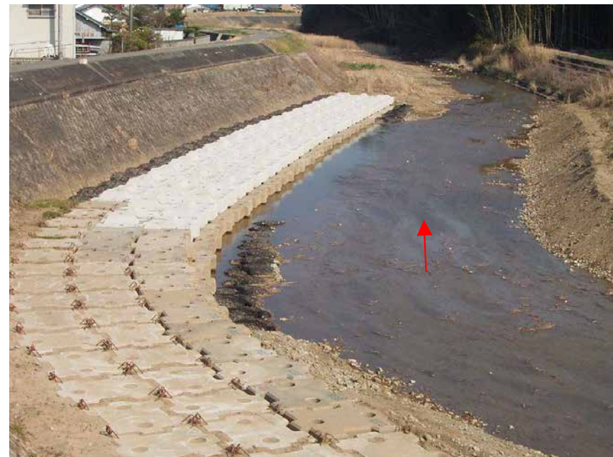
根固め工（波瀬川2.8k付近）
