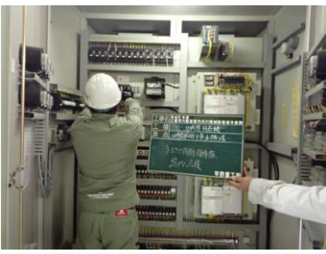
機械・電気設備の点検
