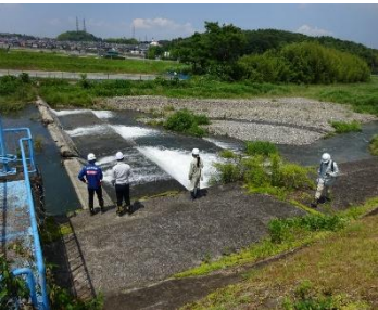
台風期点検・出水期前点検
