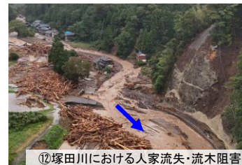
⑫塚田川における人家流失・流木阻害 (石川県輪島市)
