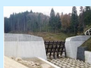
砂防関係施設整備
