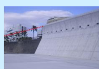
海岸保全施設整備
