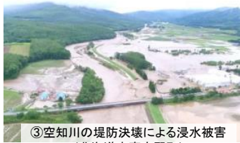
③空知川の堤防決壊による浸水被害 (北海道南富良野町)
