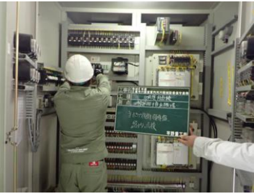
機械・電気設備の点検
