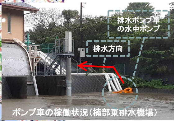
照明車・ポンプ車派遣状況 （楠部東排水機場）
