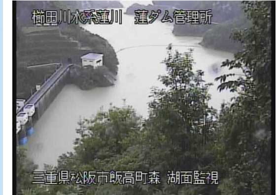
蓮ダムの貯水状況 8/15 12:00頃 貯水位 EL:304.78m (貯留最大時)
