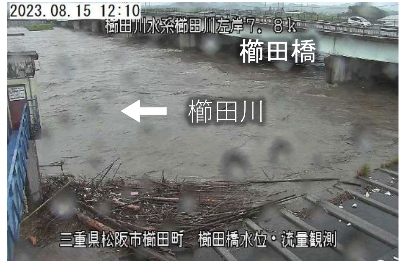
榑田橋水位観測所 出水時の状況(8月15日12時10分)
