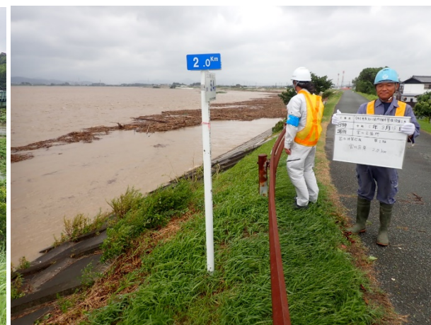
宮川左岸2.0k 付近
