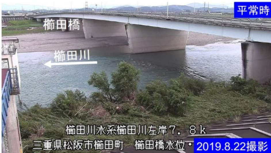
榑田橋水位観測所 平常時の状況
