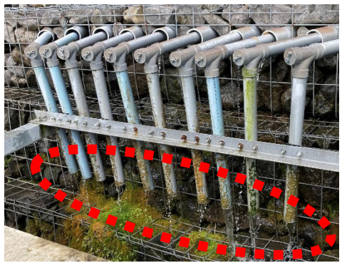
横ボーリングの排水状況
