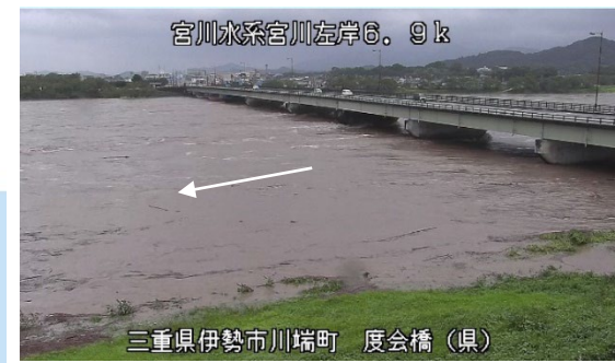
官川の出水状況 8/15 14:10頃 6.9k付近
