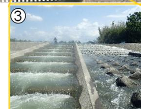
呼び水水路の設置や、流れがゆるやかな階段式、幅の広い扇形の魚道を新設・改良
