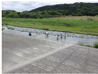
せせらぎ水路の利用 (R5. 5. 29)
