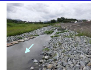
←せせらぎ水路の改良状況
