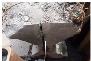
コンクリート幅が厚く、圧砕機による取り壊しが不可能
