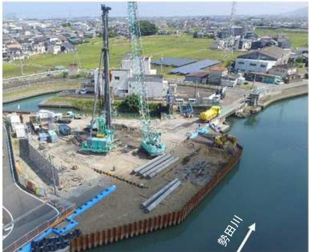
新排水機場の施工にあたり、周辺の地盤改良を実施したところ、支障物が確認され、撤去する必要が生じた
