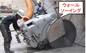
コンクリート取壊しをウォールソー工法に変更
