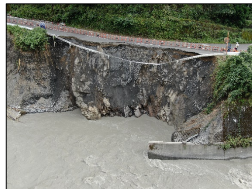
護岸の侵食状況を調査
