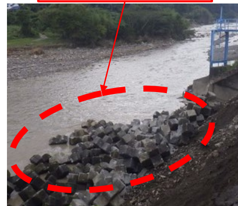
応急復旧工事状況 (9月28日17時時点)
