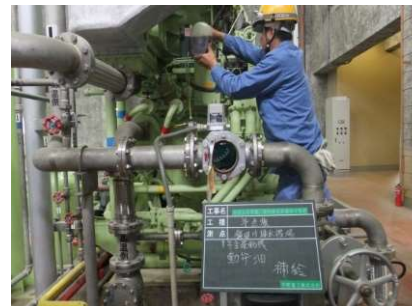
機械・電気設備の点検
