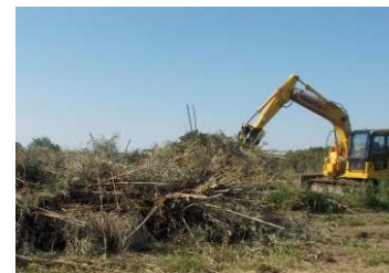
樹木伐採 (河道の維持管理)
