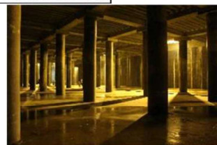
大規模地下貯留施設
