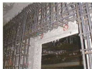
処理場の耐震化 (躯体補強)
