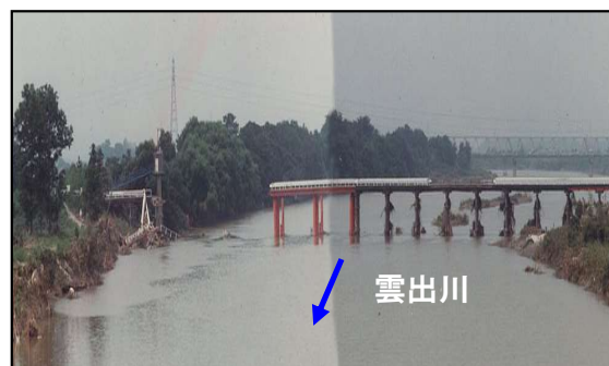
昭和57年8月洪水 橋梁流出(雲出川4.0k付近:旧雲出橋)
