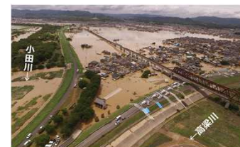
<平成30年7月豪雨>小田川における浸水被害(岡山県倉敷市)
