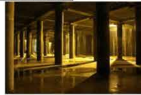
大規模地下貯留施設
