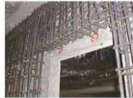
処理場の耐震化 (躯体補強)
