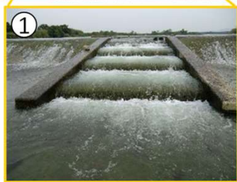
魚道内の水流が激しく、魚の休む場所がない
