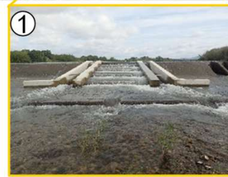
流れがゆるやかな階段式や幅の広い扇形の魚道を新設・改良
