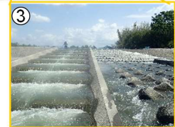
流れがゆるやかな階段式や幅の広い扇形の魚道を新設・改良
