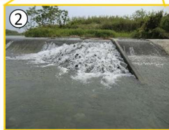
魚道内の水流が激しく、魚の休む場所がない
