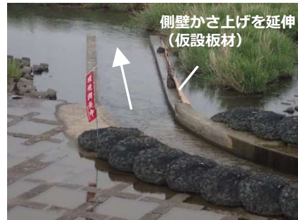
榑田第一頭首工
