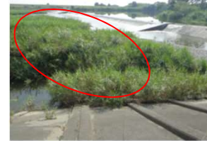
砂州の形成 (新屋敷取水堰下流)
