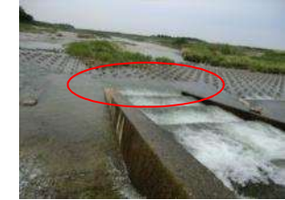
呼び水機能の状況 (新屋敷取水堰下流)
