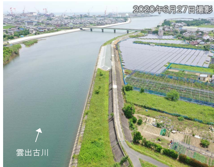
対策中【右岸：川原地区】（暫定施工）
