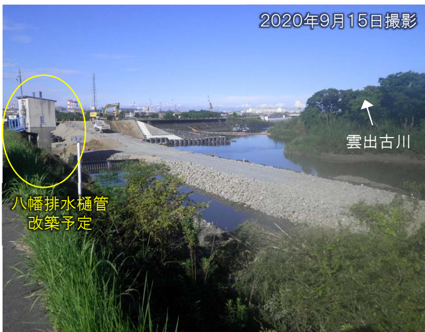
対策中【左岸：高峯地区】（準備工）
