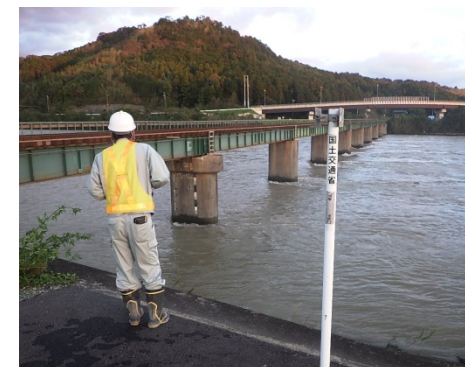
河川状況確認 (JR櫛田橋橋梁)
