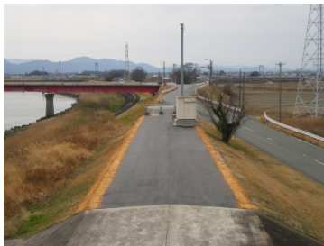
宮川左岸4.4k付近
