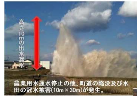
農業用水通水停止の他、町道の陥没及び水田の冠水被害(10m×30m)が発生。
