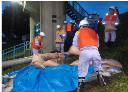
岐阜市水防団 漏水対策
