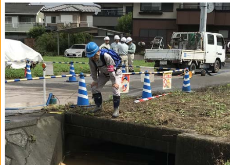
防災エキスパート 被災状況の確認
