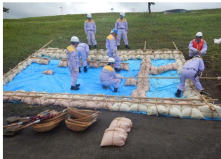
岐阜市水防団 堤防法崩れ対策
