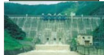
洪水調節中の蓮ダム(H9.7)
