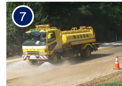
市道の路面清掃状況 (7月26日)
