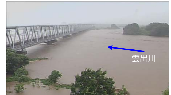
平成26年8月洪水 洪水流況（雲出川左岸7.4k付近）
