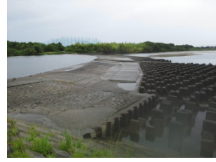
渇水時の定点観測 平成27年6月3日 香良洲頭首工
