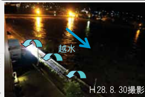
久慈川(右岸)越水状況
