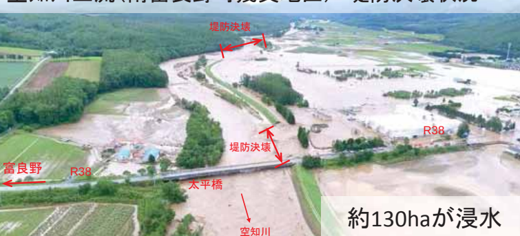
空知川上流(南富良野町幾寅地区) 堤防決壊状況
