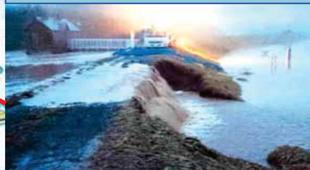
常呂川の堤防決壊(左岸18.6k) (北見市常呂自治区)
