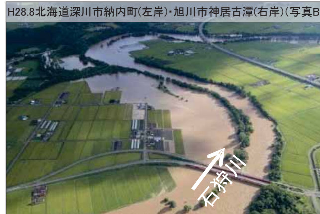
平成28年8月出水の状況
