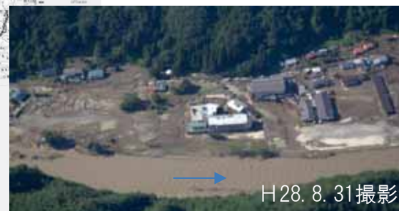
小本川 被害状況①
