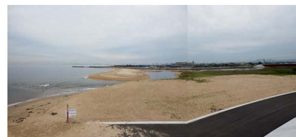
鈴鹿川派川河口部の状況
