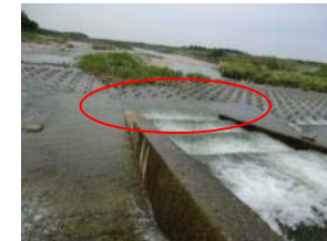
呼び水機能の状況 (新屋敷取水堰下流)
