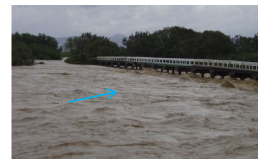
(H16.9洪水：太平橋付近の出水状況)
